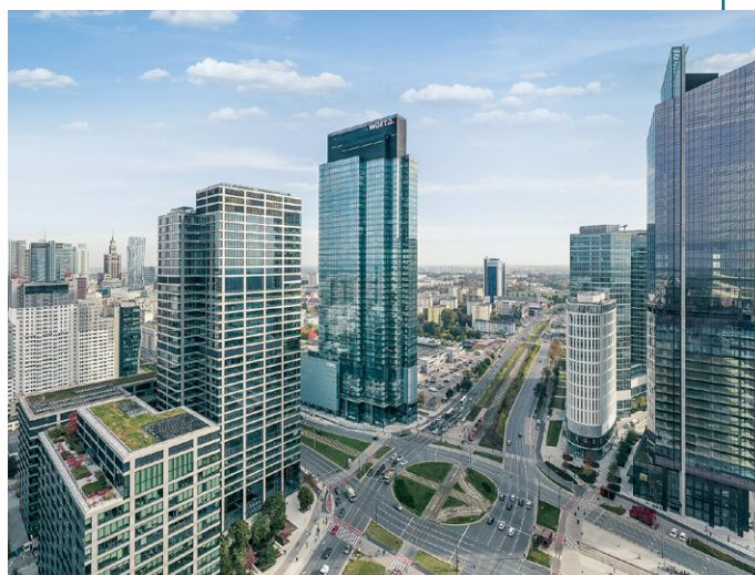
BREEAM-zertifiziertes Bürogebäude und Sitz der WARTA in Polen
